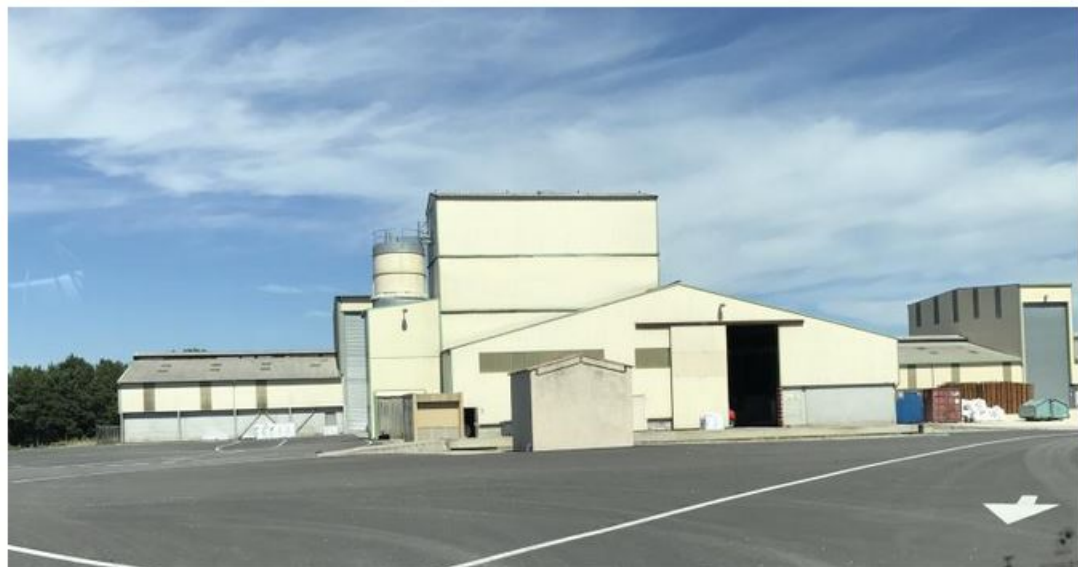
La nouvelle unité de production de fertilisants organiques du groupe Frayssinet à Donzère. / © Groupe Frayssinet
